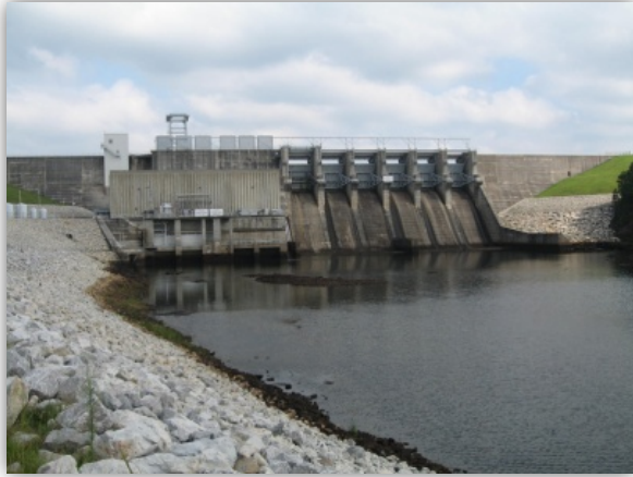
Figure 2-7 R. L. Harris Dam
